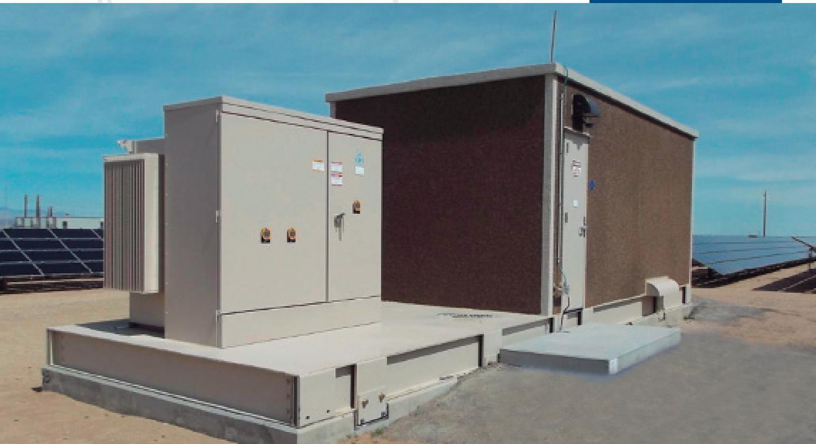
Todos los diseños de SolarPAD WEG de 4 bobinas y 2 bobinas de 1000 kVA construidas con núcleo apilado que utiliza bobinas redondas o semiredondas, que proporcionan la máxima fuerza de cortocircuito, mayor exposición de la bobina al refrigerante y altas distancias eléctricas internas.
